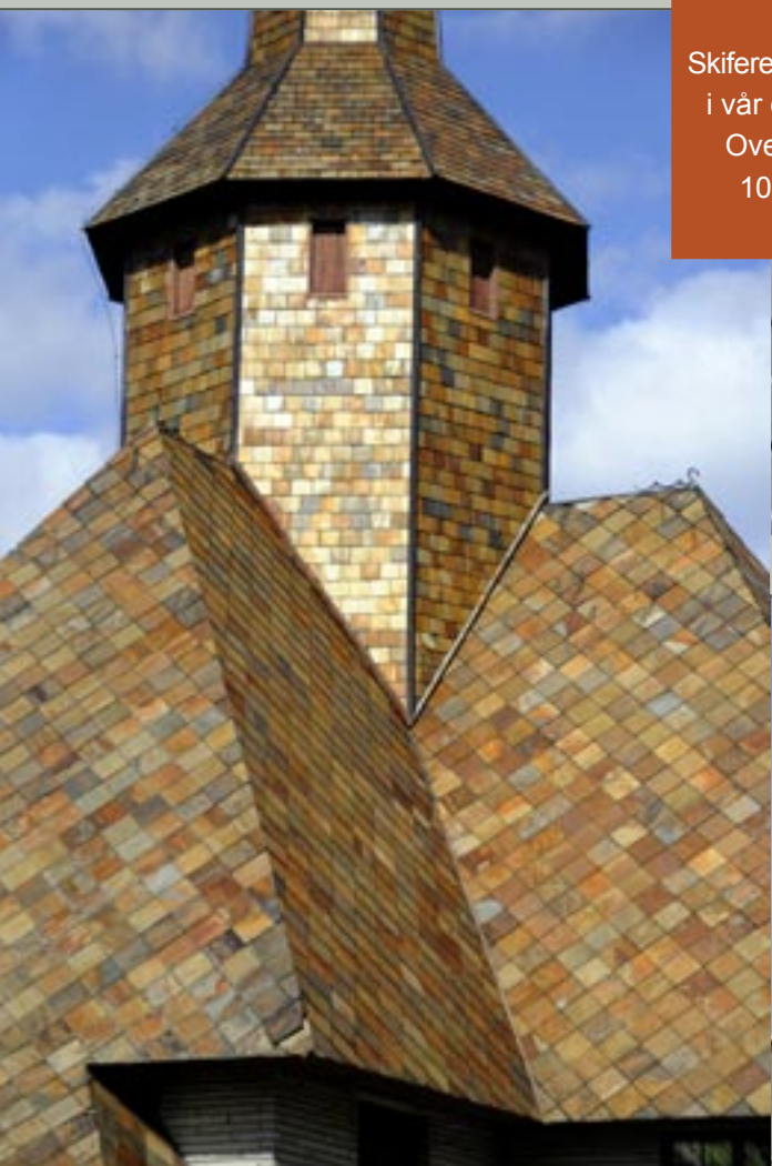
Tak med firkantstein i Minera Skifer Otta rust.
