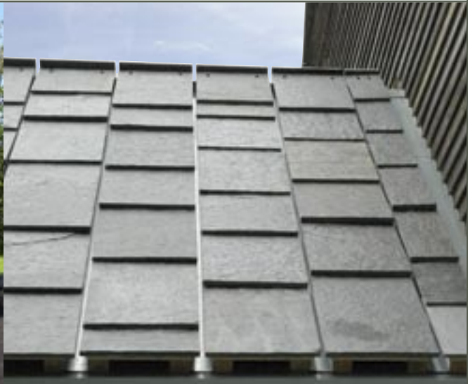
Fallende lengder saget (Turmometoden) i Minera Skifer Otta.
