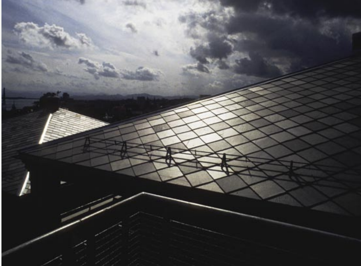
Tak med firkantstein i Minera Skifer Alta.
