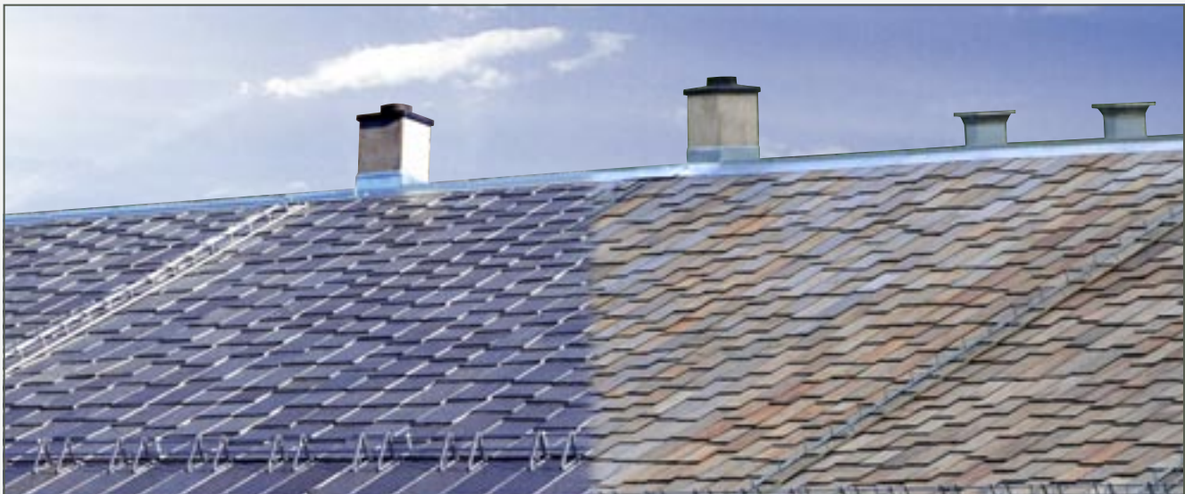
Fallende lengder saget (Turmometoden) i Minera Skifer Otta. Endring i farge fra 2000 (venstre del) til 2009
