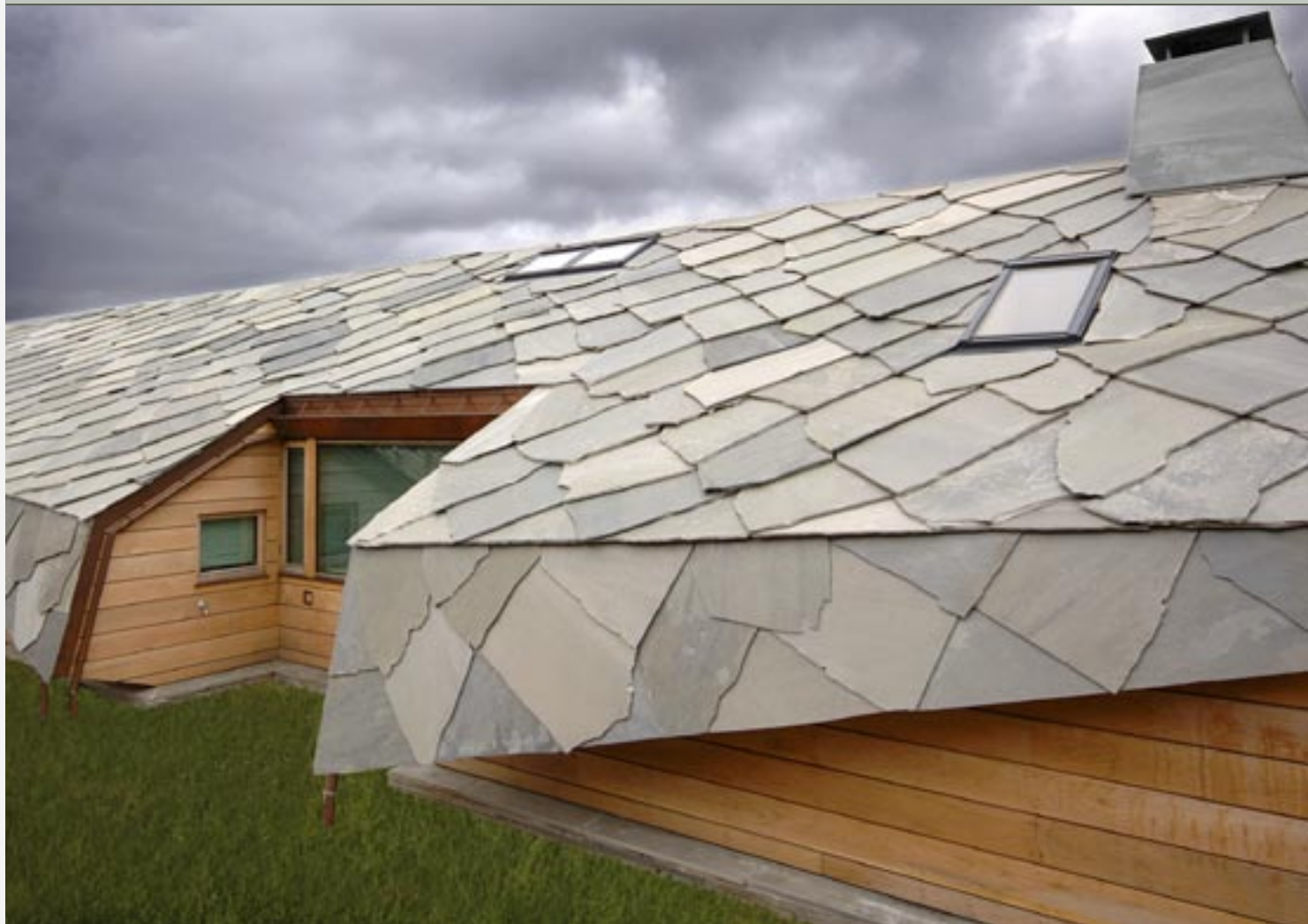
Tak med bruddheller i Minera Skifer Oppdal.
