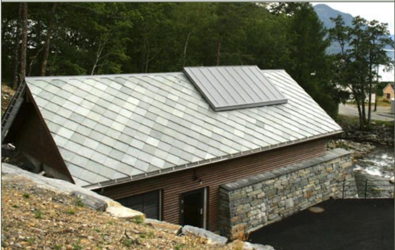
Tak med firkantstein i Minera Skifer Alta.
