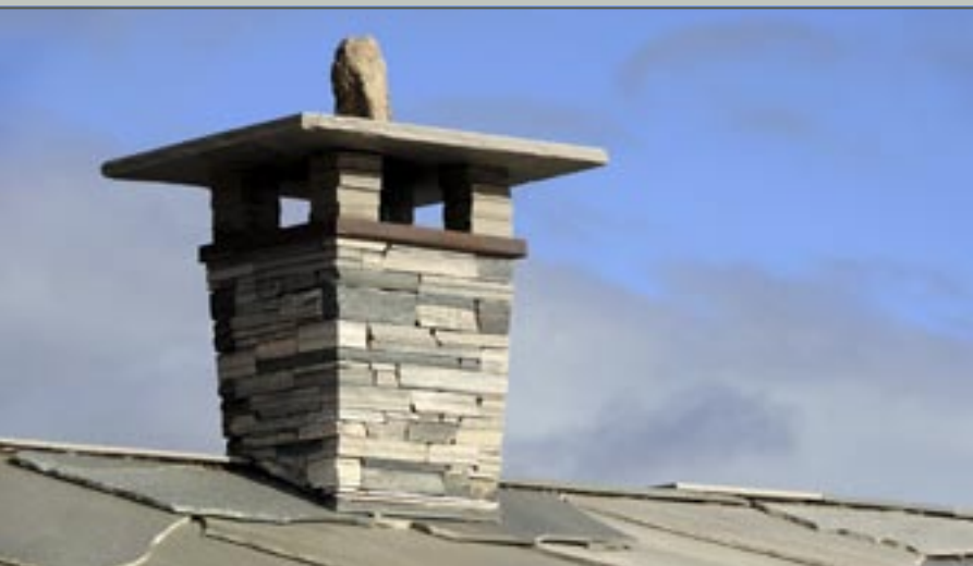
Pipe med tørrmur og pipehelle i Minera Skifer Oppdal.
